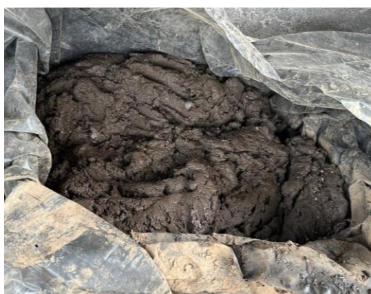
Fig. 34. reposo de la mezcla
