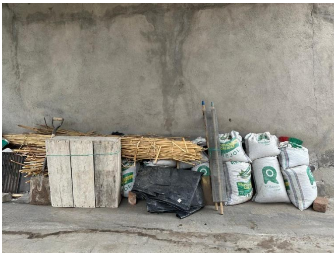
Fig. 11. Equipos y materiales para la elaboración de Adobe
