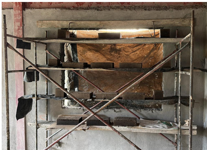
Fig. 36. Etapas de secado y acopio de adobes
