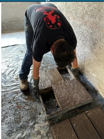
Colocación de los bloques con la mezcla
