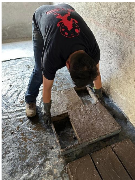
Fig. 35. Moldeo de los adobes
