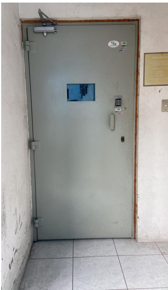
Figura 3.2: Acceso al cuarto del centro de cómputo Matriz Elaborado por: El investigador.
