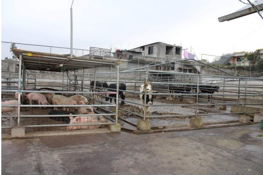
Instalaciones del camal municipal de Pelileo
