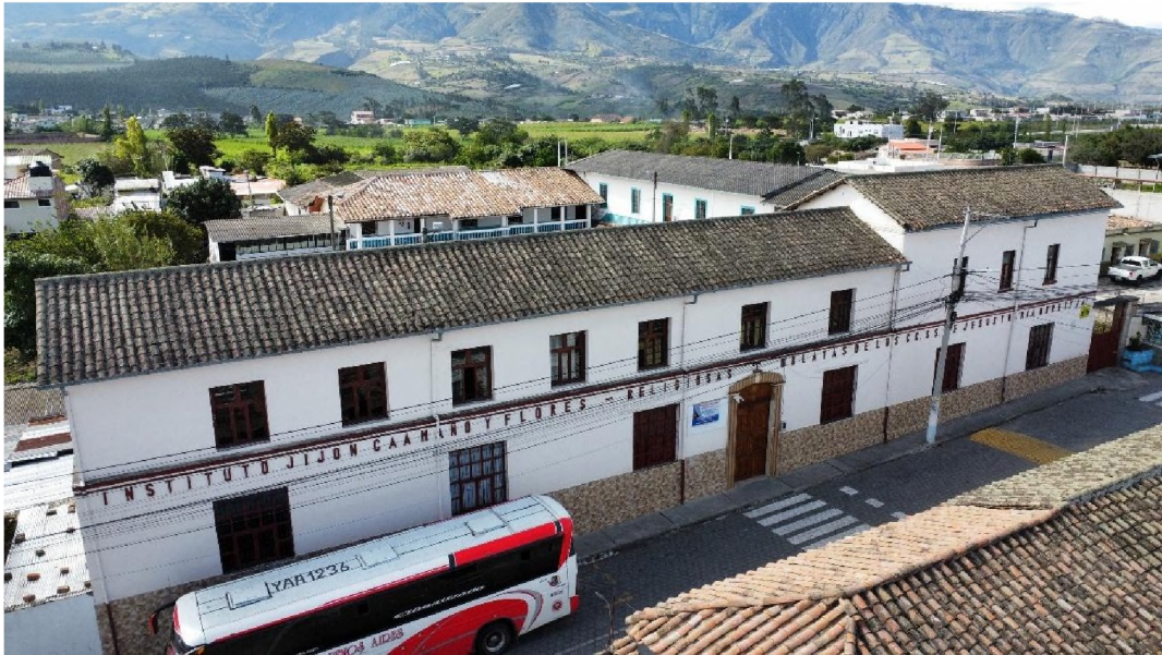
Imagen 7. Fachada principal de la Unidad Educativa Jijón Caamaño y Flores.
