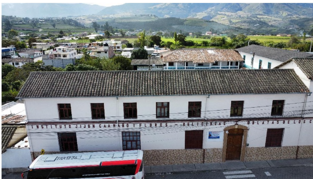
Imagen 16. Fachada principal de la Unidad Educativa Jijón Caamaño y Flores.
