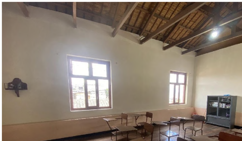
Imagen 22. Distribución de ventanales y luminarias en 10vo de Básica.
