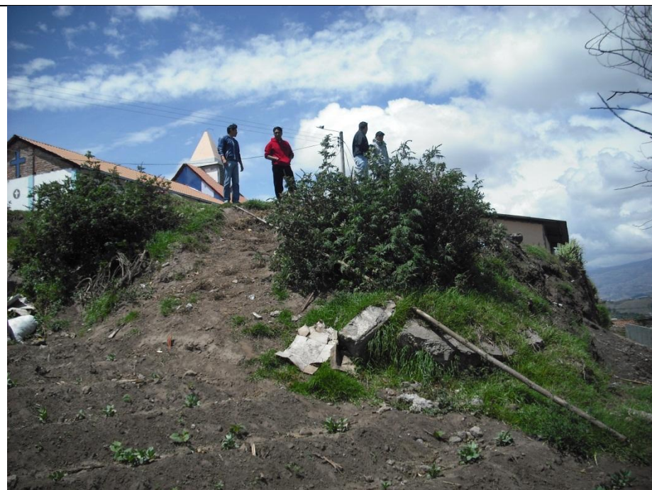
Relleno y Compactación
