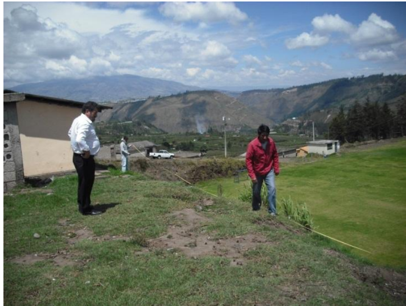
Medición de la longitud para Muro.
