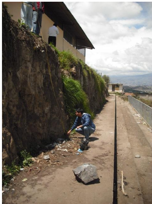
Medicion de la altura del Muro
