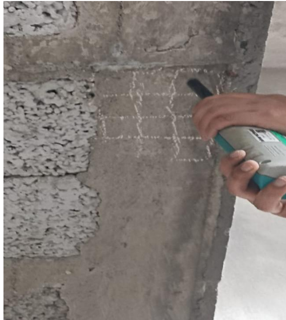
Ilustración 2. Ensayo Esclerométrico a Losa
