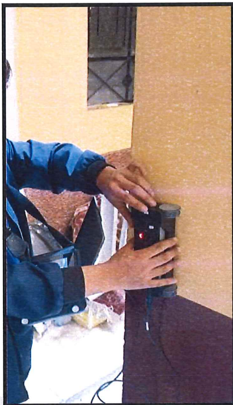
Fig. 7. Detección de armaduras en las columnas
