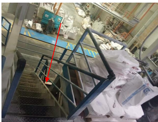
Figura 7 Riesgo de caída
