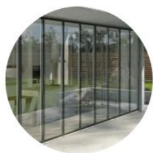
Cerramiento de aluminio y vidrio
