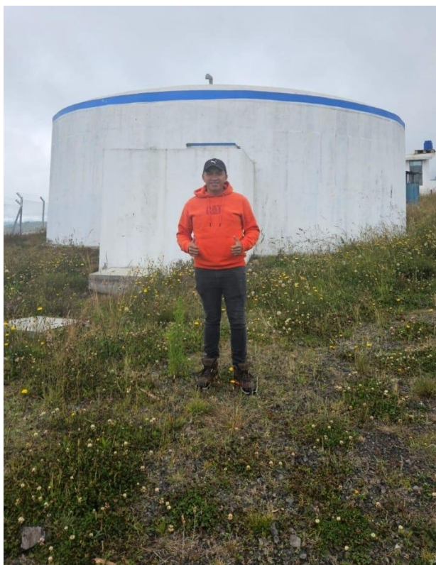
Fig. 15. Revisión de los tanques de reserva.
