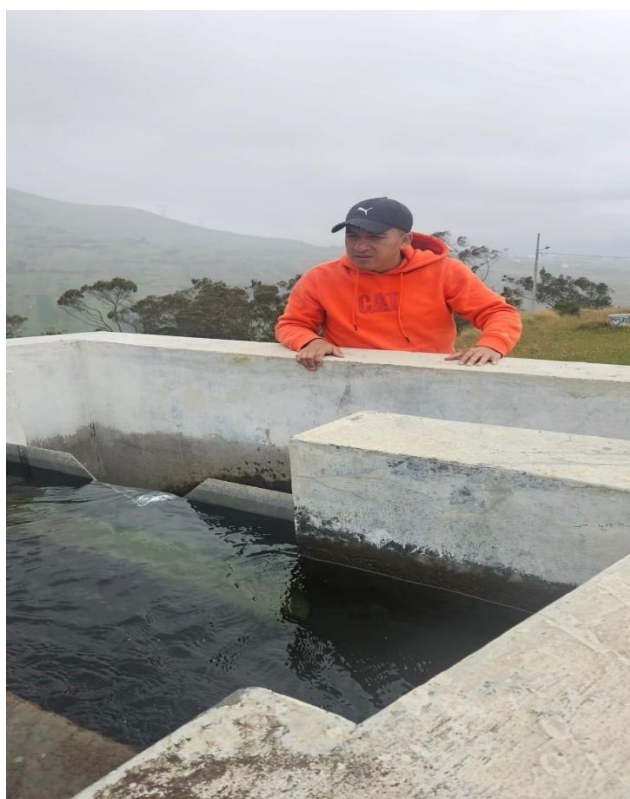
Fig. 14. Evaluación técnica de la captación y conducción.
