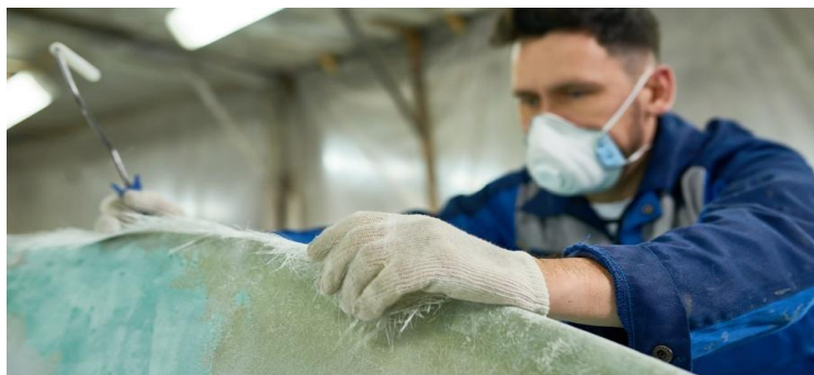
Figura 20. Proceso de aplicación manual de fibra de vidrio en superficie moldeada.
