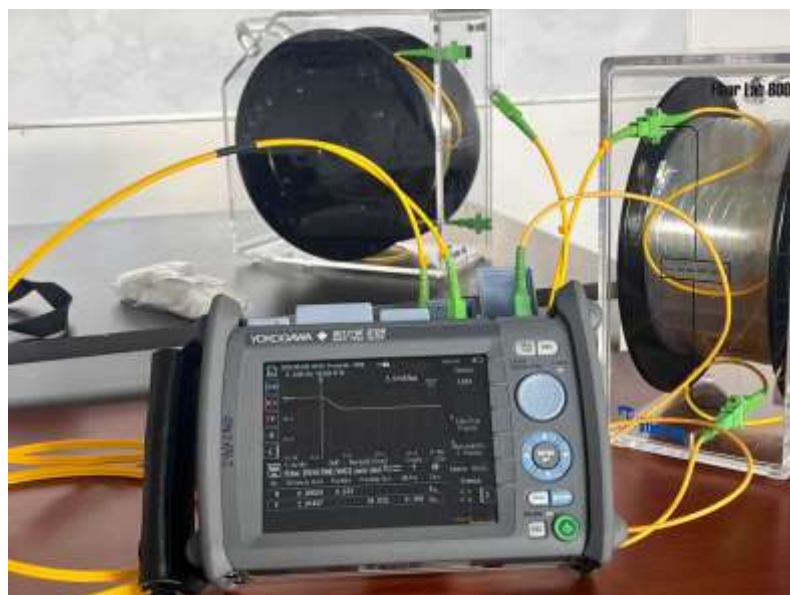
Figura 55. Medición OTDR del escenario 1 con tramo aproximado de 2.01 km
