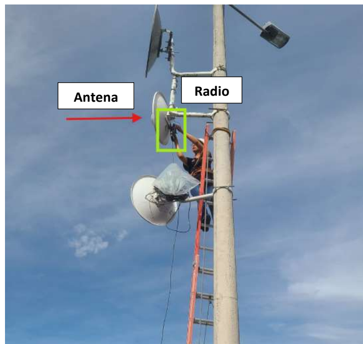
Figura 40. Instalación del nodo principal o NP
