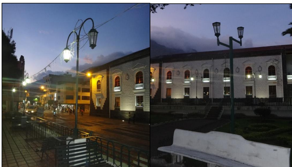
Gráfico N° 78: Luminarias en mal estado Elaborado por: Argotti, A. (2016)
