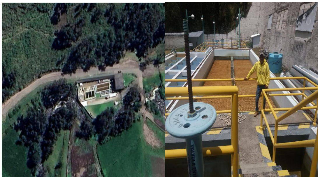
Figura 1. Ortofoto de ubicación de la planta potabilizadora.
