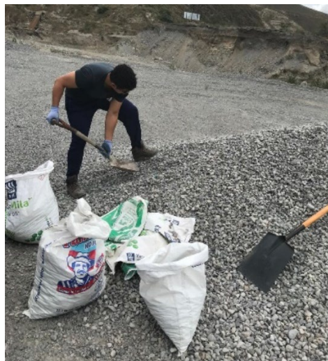
Fig. 2. Recolección del agregado grueso en la Cantera de la Constructora Alvarado.
