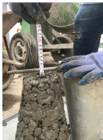
Fig. 6. Asentamiento del hormigón.
