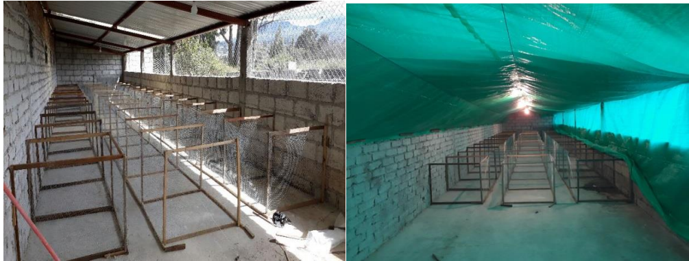
Anexo 1. Adecuación del galpón.
