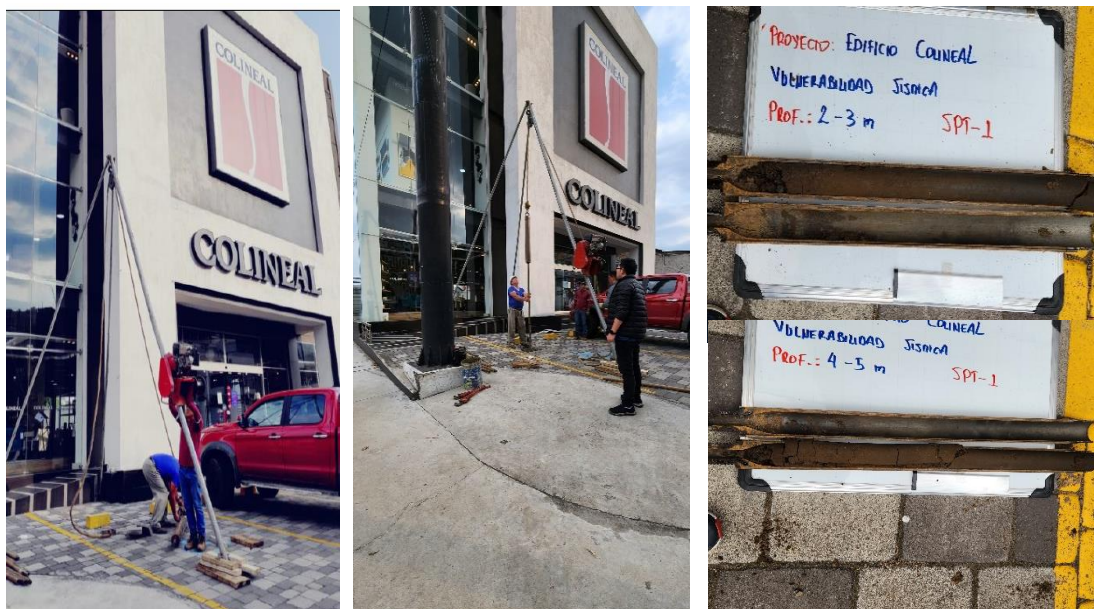
Figura 16. Fotografías del ensayo SPT, extracción muestras del suelo
