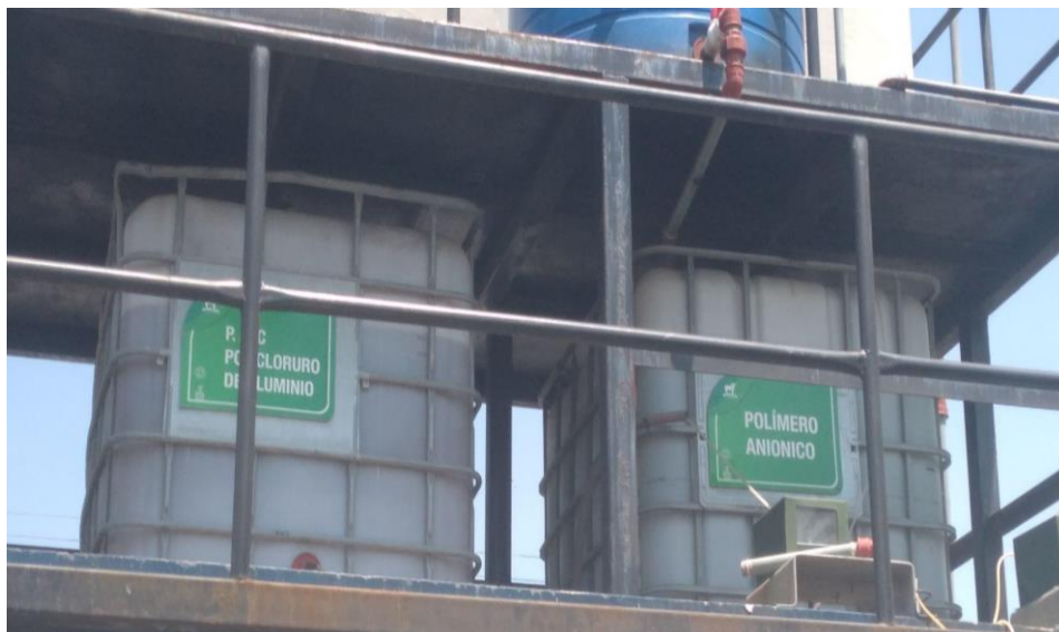
Figura 5 PAC y polímero aniónico que se utiliza para realizar el proceso de floculación.
