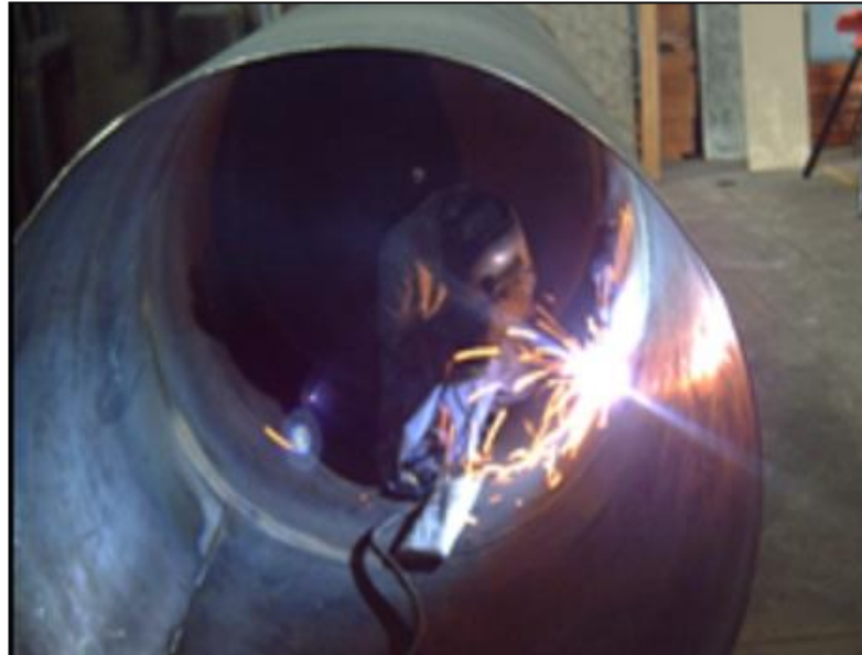
Figura 6.36. Obrero soldando Tanque.
