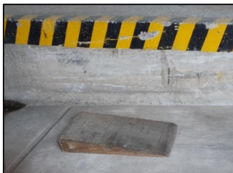
Fig. 37: Rampa de madera.
