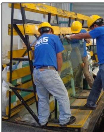
Fig. 39: Colocación de vidrios en el caballete del vehículo.
