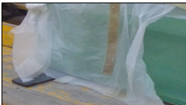
Fig. 43: Colocación de plástico entre los vidrios (laminado).
