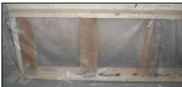
Fig. 32: Recubrimiento en el interior de la caja.
