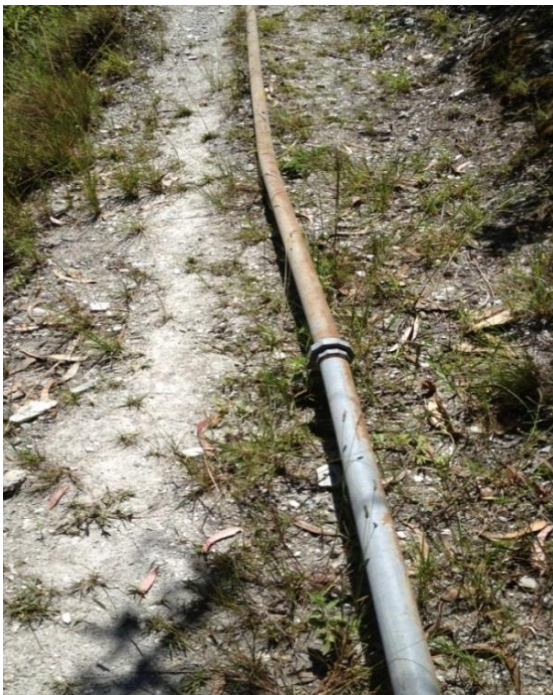
Red de distribución con óxido que puede contaminar el agua que están consumiendo los moradores de la parroquia todos los días, además están remendadas con tiras de caucho.
