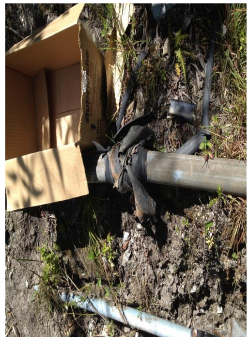
Red de distribución con óxido que puede contaminar el agua que están consumiendo los moradores de la parroquia todos los días, además están remendadas con tiras de caucho.
