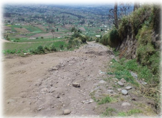
Capa de rodadura en mal estado
