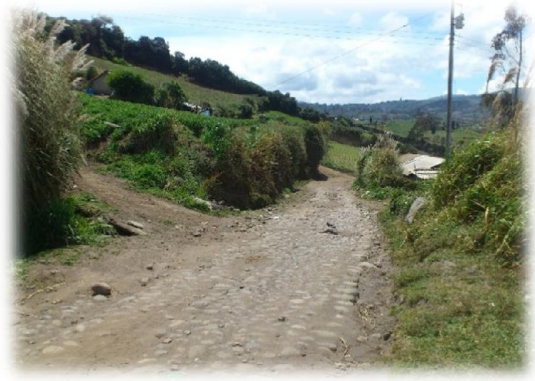
Capa de rodadura en mal estado
