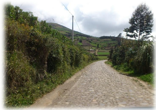
Capa de Rodadura de la Vía
