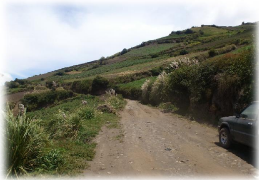
Estado actual de la vía
