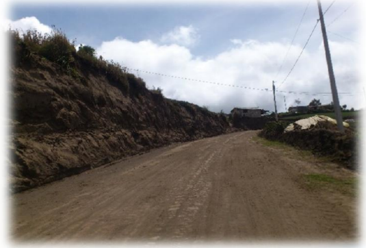
Vista de la vía
