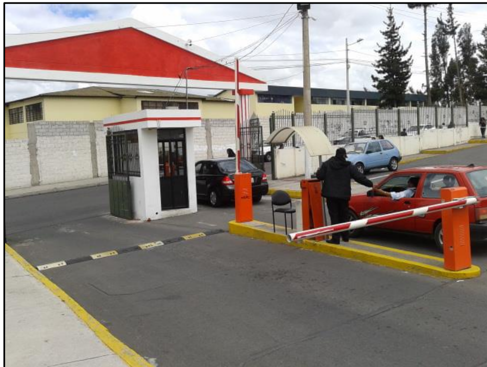
Figura 4.8 Sistema de Control de Acceso Calle Guayllabamba Elaborado por: El Investigador
