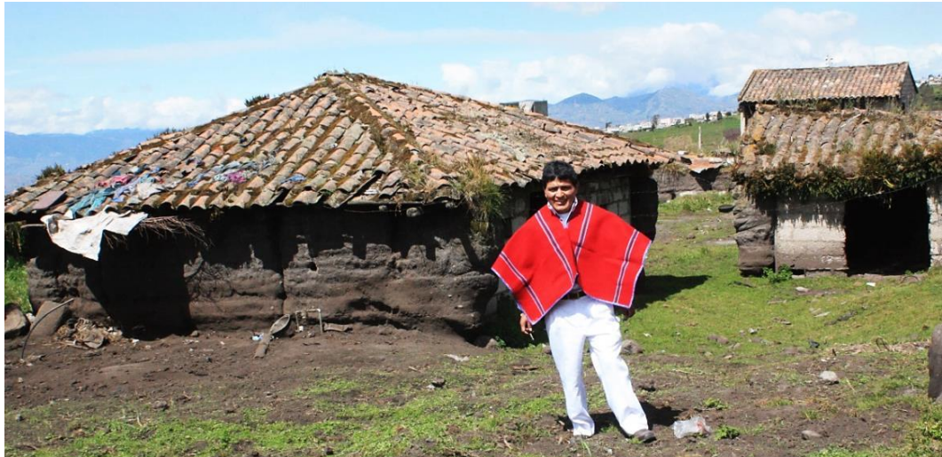
Fotografía 17: Casa tipo 3, casa rectangular. Tapial y teja, páramos Andinos. Autor: Bernardo Tuza
