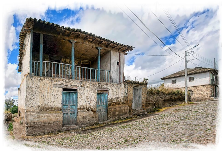
Fotografía 30: Edificaciones urbanas de Pilahuín. Paredes de piedra, adobón y bahareque, estructura de madera y teja. Autor: Fernando Dávila.
