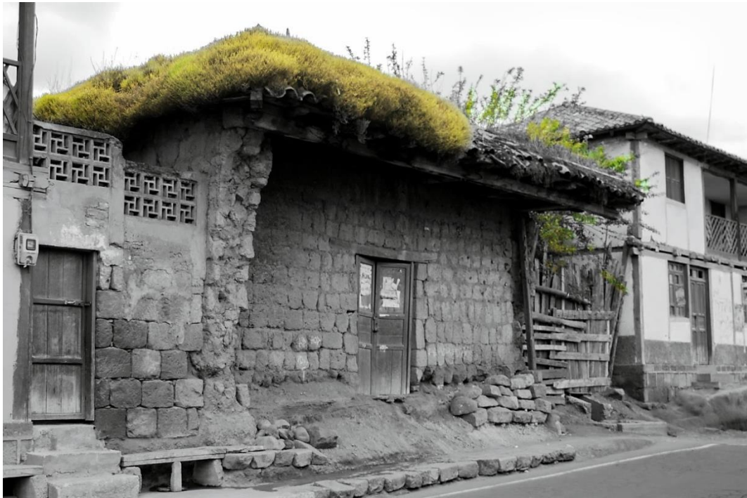
Fotografía 37: Deterioro de vivienda de adobón en Pilahuín Fuente: http://www.derecho-ambiental.org/PDA-Pilahuin/Mapas-PDA-Pilahuin-Menu.html
