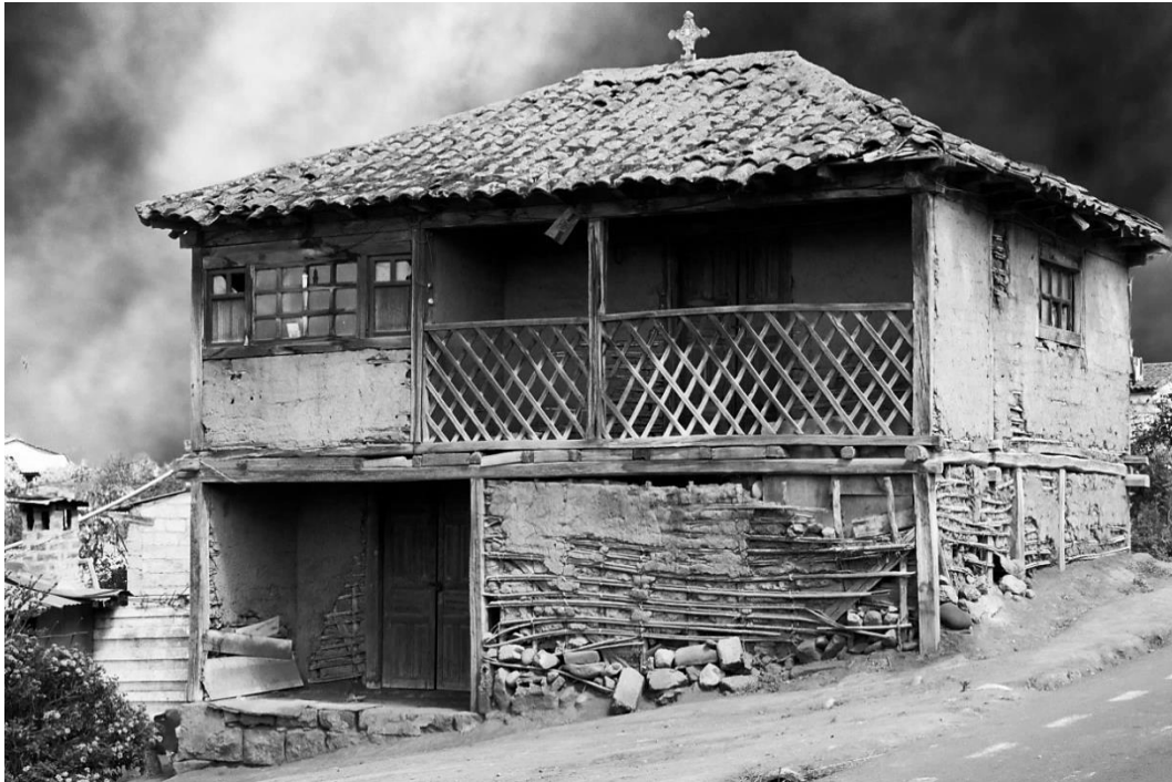
Fotografía 89: Balcones retranqueados, cubierta de teja, pasamanería. Estructura de madera, paredes de bahareque y cubierta de teja, época colonial, páramos Andinos. Autor: Santiago Suárez Abril.
