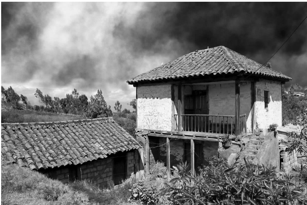
Fotografía 92: Balcones retranqueados, cubierta de teja, pasamanería. Estructura de madera, paredes de bahareque y cubierta de teja, época colonial, páramos Andinos. Autor: Santiago Suárez Abril.
