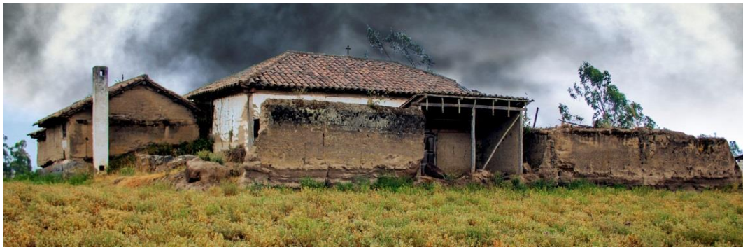
Fotografía 21: Casa tipo 5, casa en L. Bahareque y paja, muro de tapial. Autor: Jimmy Silva, Juan Flores. Retoque: Santiago Suárez Abril.
