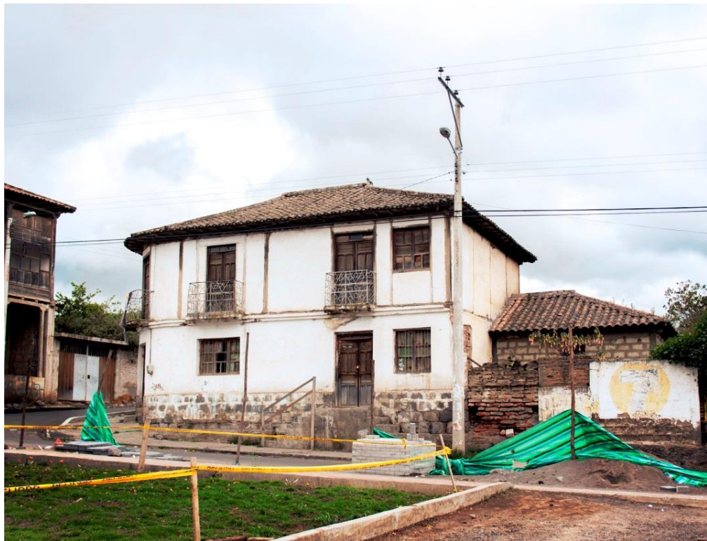
Fotografía 32: Casa tipo 7, casa en dos plantas. Estructura de madera, paredes de bareque y cubierta de teja, balcón saliente. Autor: Jimmy Silva, Juan Flores.
