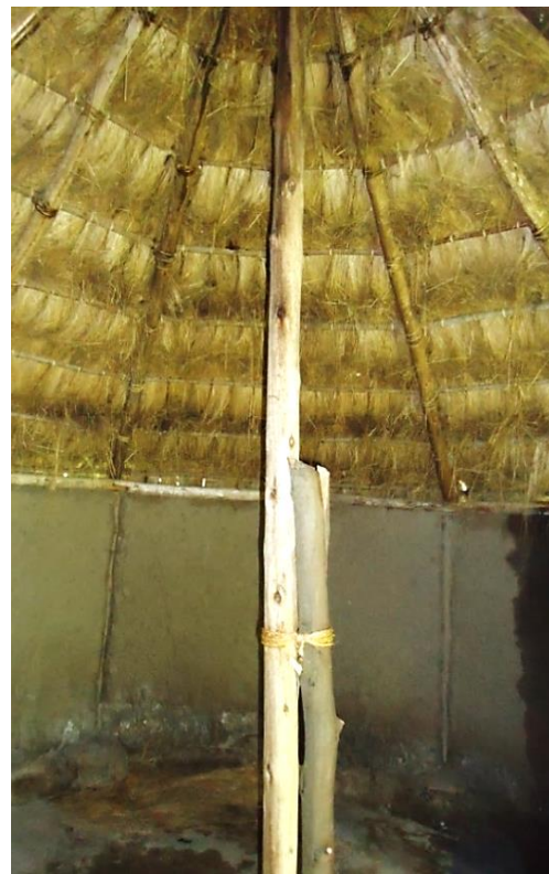
Fotografía 12: Interior de poste central y cubierta de paja Casa tipo, maqueta escala 1:1 de vivienda indígena Rumipamba /2012 Autor: Pablo Cardoso
