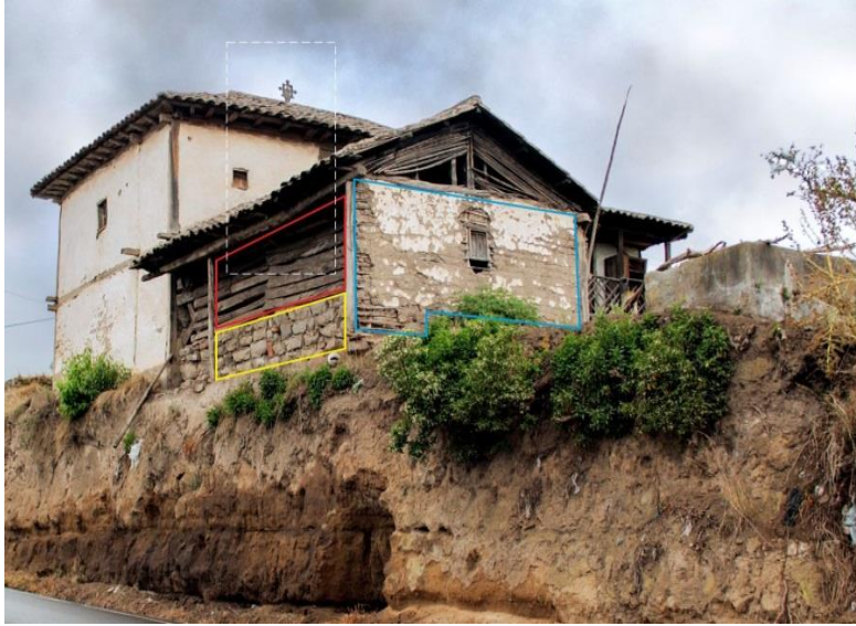
Fotografía 93: Materiales en paredes Cambio de materiales en paredes, estructura de madera en pórticos. Autor: Jimmy Silva, Juan Flores. Retoque: Santiago Suárez Abril.
