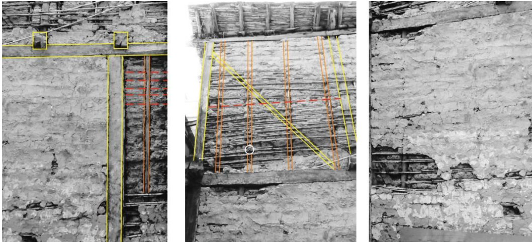
Fotografía 100: Estructura de Bahareque Autor: Santiago Suárez Abril
