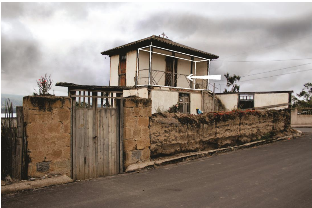
Fotografía 94: Retranque de balcón. Estructura de madera, paredes de bahareque y cubierta de teja. Autor: Jimmy Silva, Juan Flores. Retoque: Santiago Suárez Abril.
