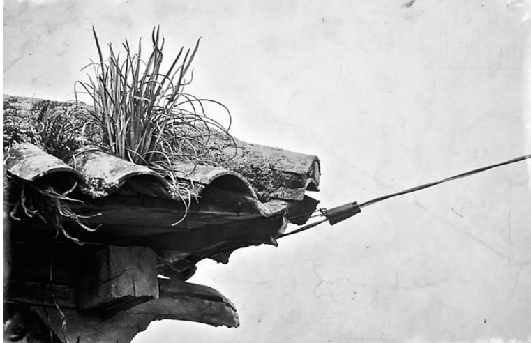
Fotografía 97: Detalle de cubierta. Autor: Fernando Dávila
