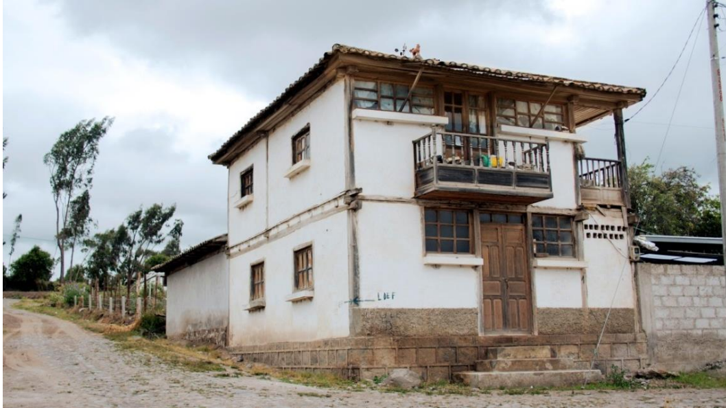
Fotografía 33: Casa atípica, casa en dos plantas. Estructura de madera, paredes de bareque y cubierta de teja, balcón saliente Autor: Jimmy Silva, Juan Flores. Retoque: Santiago Suárez Abril.
