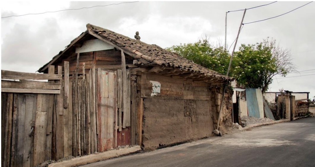
Fotografía 20: Casa tipo 4, casa rectangular a dos aguas. Tapial y teja, Parroquia Juan Benigno Vela. Autor: Jimmy Silva, Juan Flores. Retoque: Santiago Suárez Abril.
