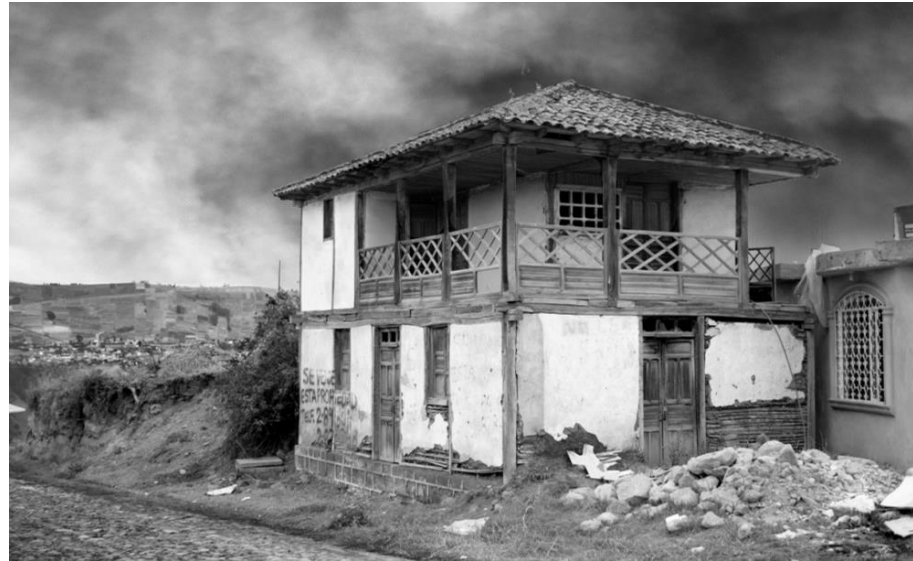
Fotografía 29: Casa tipo 6, casa en dos plantas. Estructura de madera, paredes de bahareque y cubierta de teja, páramos Andinos. Autor: Santiago Suárez A.
