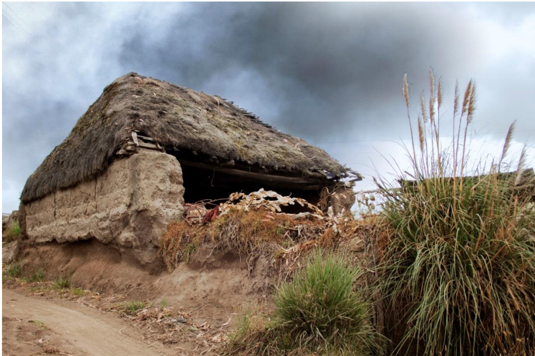
Fotografía 16: Casa tipo 2, choza rectangular. Tapial y paja, Parroquia Juan Benigno Vela. Autor: Jimmy Silva, Juan Flores. Retoque: Santiago Suárez Abril.
