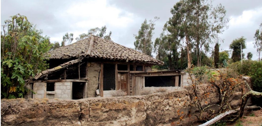
Fotografía 35: Deformación de edificación. Bahareque y teja, muro de tapial. Autor: Jimmy Silva, Juan Flores. Retoque: Santiago Suárez Abril.
