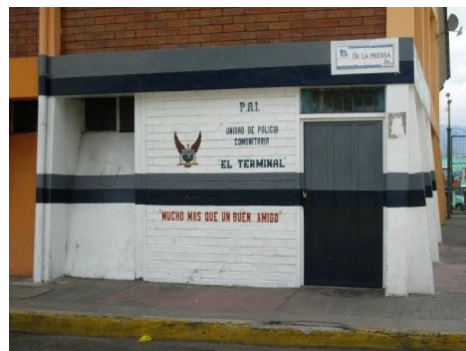
Fotografía No.4 Fuente: Arq. Robert Unda
