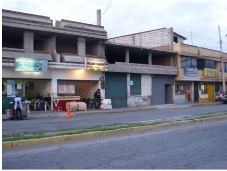
Fotografía No. 28 Fuente: Arq. Robert Unda
