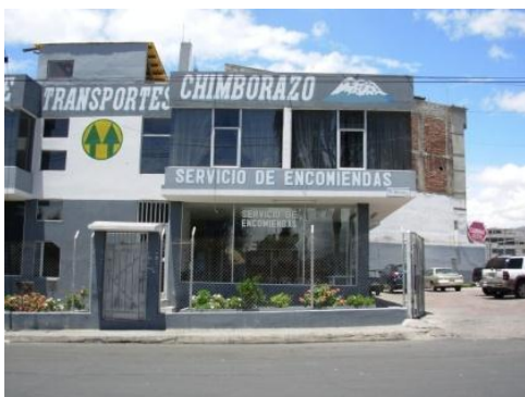
Fotografía No. 11 Fuente: Arq. Robert Unda
