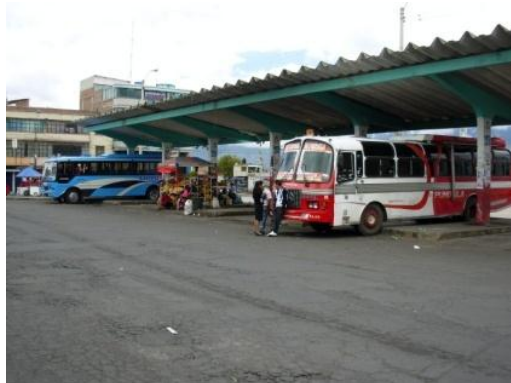
Fotografía No. 1 Fuente Arq. Robert Unda
