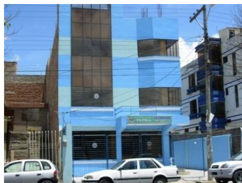
Fotografía No.12 Fuente: Arq. Robert Unda
