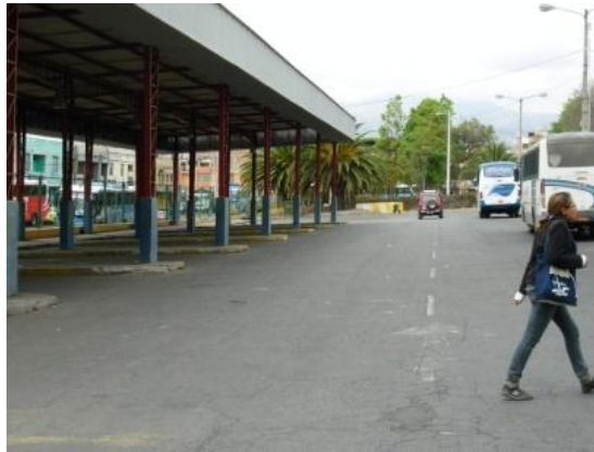
Fotografía No. 15 Fuente: Arq. Robert Unda
