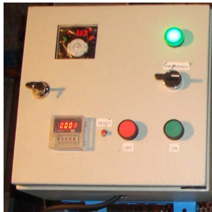
Figura 6.26 Calibración del parámetro de velocidad, (Hz del Motor)
