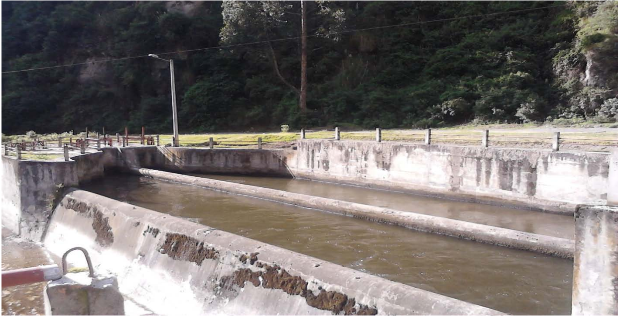
Imagen D-1. Recorrido del Canal Ambato-Huachi-Pelileo. Captación Manzana Guayco. Sector Quindivana.
