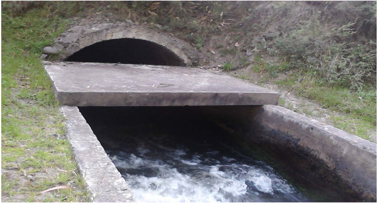
Imagen D-3. Recorrido del Canal Ambato-Huachi-Pelileo. Quebrad de Patalo, Sector Juan Benigno Vela.
