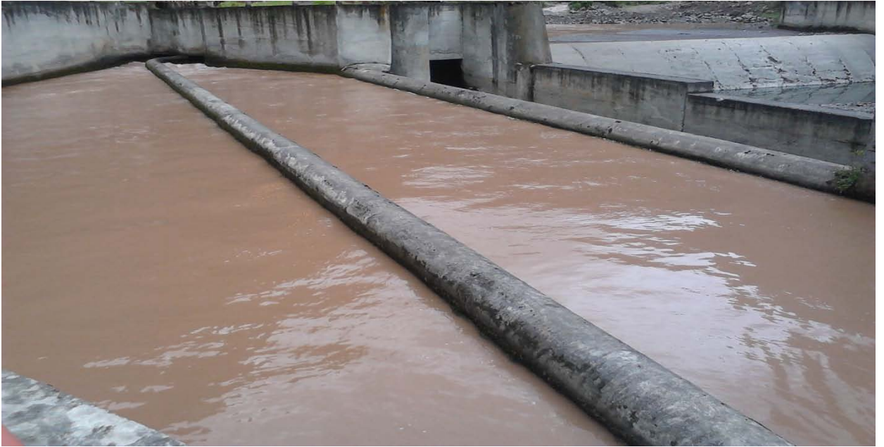
Imagen D-16. Agua de ingreso al canal. Mes de Mayo.
