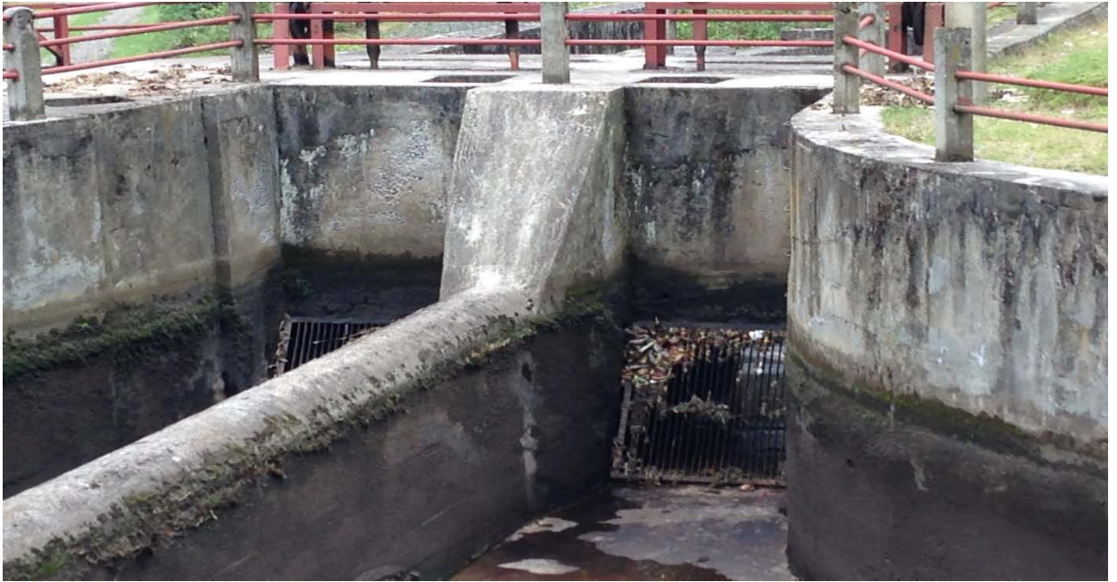
Imagen D-18. Mantenimiento del canal Ambato-Huachi-Pelileo. Captación, Manzana Guayco.
