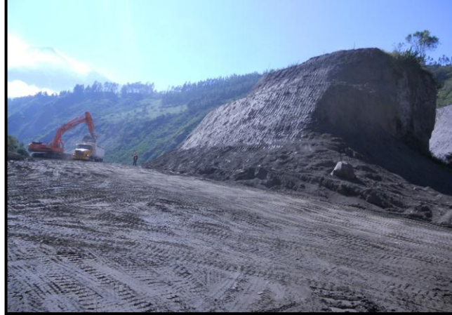
Foto 6.10.3 Controlar cortes de talud para reducir el impacto al paisaje del lugar. Fuente: Libro de obra en construcción de la vía Cahuají-Pillate-Cotaló.
