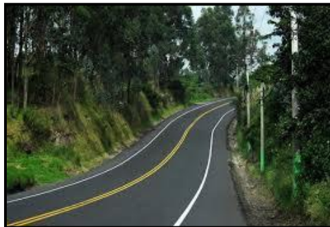
Foto 1.4 Camino bien diseñado de “impacto mínimo”, que tiene una especificación adecuada para su uso, buen drenaje y taludes estables. Fuente: Google, caminos.
