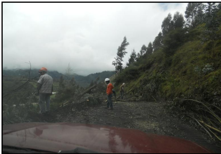
Foto 6.10.2 Deforestación inadecuada, aumentando el monto original del contrato, incluso creando rubros no establecidos. Fuente: Libro de obra en construcción de la vía Cahuají-Pillate-Cotaló.
