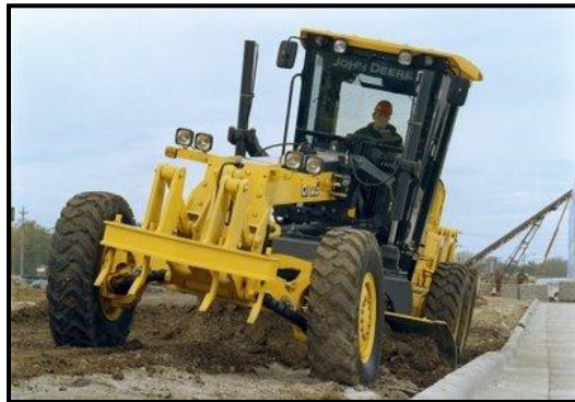
Foto 9.2 Motoniveladora. Fuente: Google
