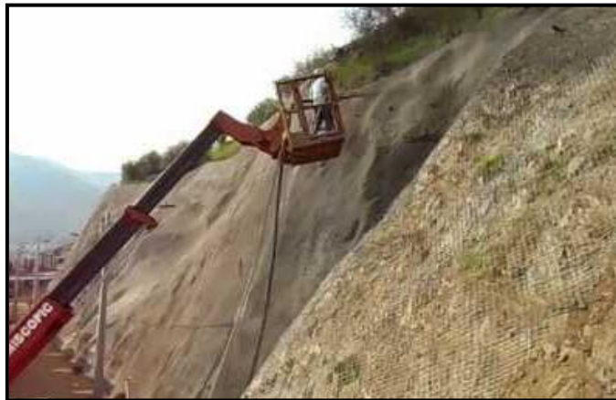
Foto 6.9 Estabilización con lechadas de hormigón y malla electrosoldada. Fuente: Google.
