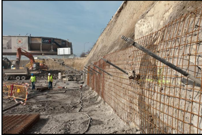
Foto 6.4 Colocación de anclajes arriostrados con malla electrosoldada. Fuente: Google, Anclaje de talud.
