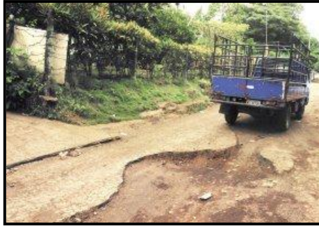
Foto 1.3 Impacto ambiental adverso producido por la erosión de la superficie del camino, derivada de pendientes fuertes y de drenes transversales inadecuadas. El mantenimiento de este camino también se vuelve difícil. Fuente: Google, caminos dañados.
