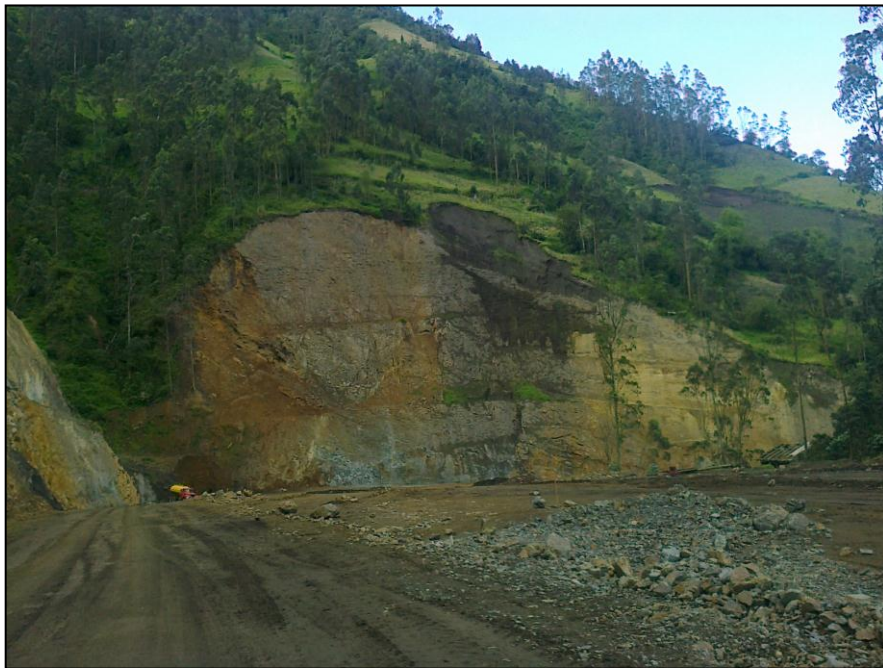
Movimiento de tierras y conformación de taludes
