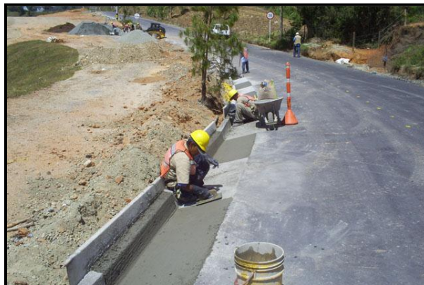
Foto 1.5 La construcción y mantenimiento de cunetas es esencial para mantener en funcionamiento el camino. Fuente: Google, construcción de cunetas.
