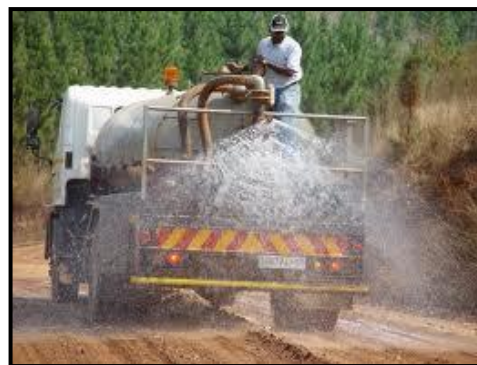
Foto 3.2 El control del polvo mediante el riego permanente durante la construcción es una medida que produce un impacto mínimo”, que tiene una especificación adecuada para su uso, buen drenaje y taludes estables. Al efectuar el control de polvo con carros cisternas, la velocidad máxima de aplicación será de 5 Km/h. Fuente: Google, control de polvo.
