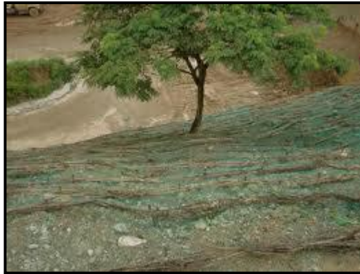
Foto 6.8 Revegetación y forestación de un talud. Fuente: Google.
