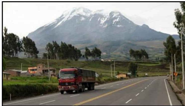
Foto 1.2 Un camino bien construido contribuye al servicio de la población local. Fuente: Google, caminos del Ecuador.
