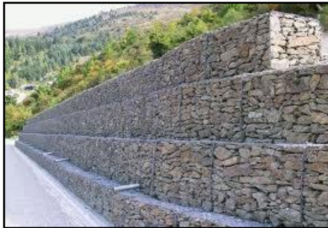
Foto 6.7 Muro de gaviones. Fuente: Google.
