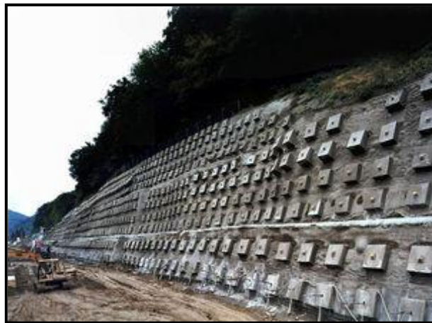
Foto 6.5 Muro anclado en la parte inferior y superior de un talud. Fuente: Google, Muro anclado.
