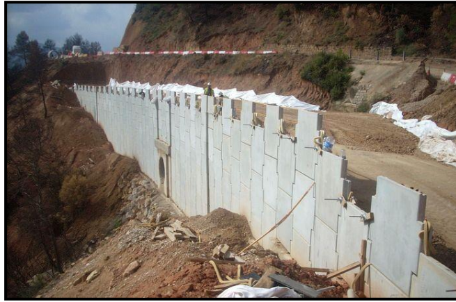
Foto 6.6 Muro de tierra armada. Fuente: Google.
