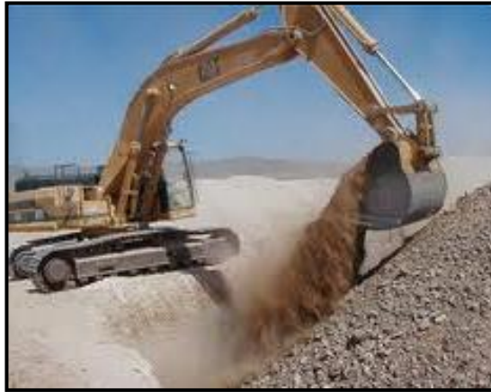
Foto 1.5 El movimiento de tierras produce algunos problemas, ruido, polvo, afectación a riachuelos, etc. Proceso que debe ser controlado. Fuente: Google, movimiento de tierras.
