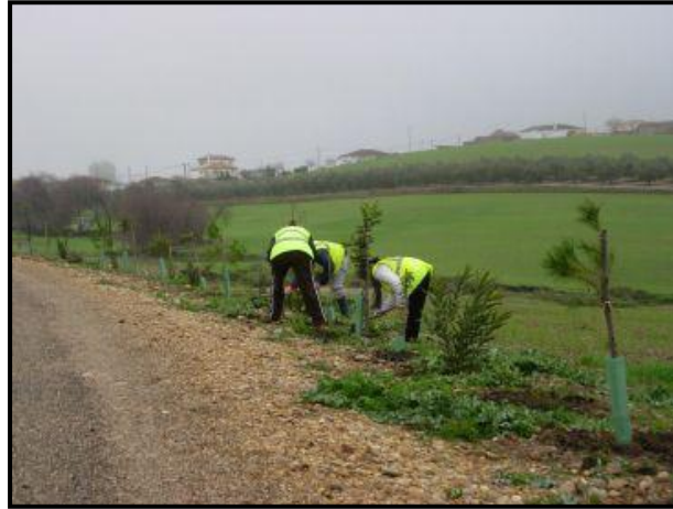
Foto 3.6 La creación de pantallas arbustivas o de tierra vegetal de forma perimetral constituyen medidas muy efectivas, no solo para hacer frente a efectos como el ruido o el polvo, sino como pantalla visual. Fuente: Google, medidas de forestación.
