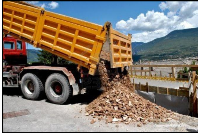
Foto 3.7 Control de los puntos de descarga, orientado a la regulación de las alturas en la caída del material. Fuente: Google, transporte de materiales.
