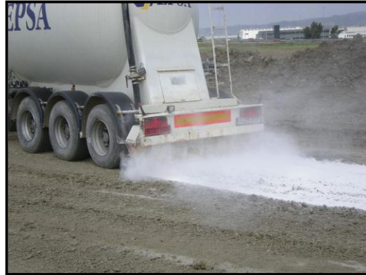
Foto 7.1 Riego de cal en sub-rasante, mejora suelos expansivos. Fuente: Google.
