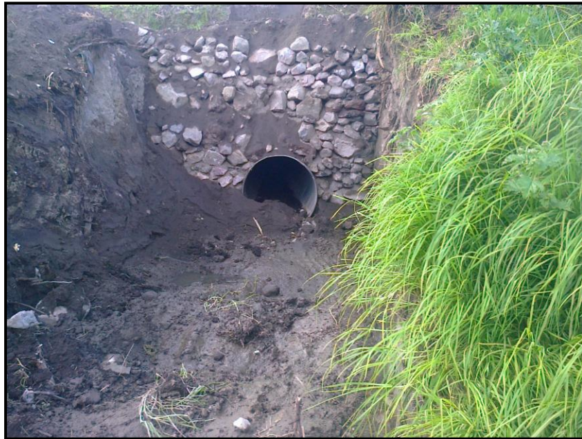
Ubicación de alcantarillas
