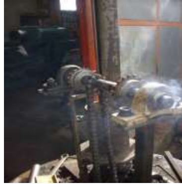
Figura 6.57 Montaje de rodamientos. Fuente: Francisco Alcocer.
