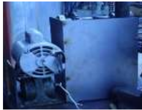
Figura. 6.51 Construcción de base del motor Fuente: Francisco Alcocer
