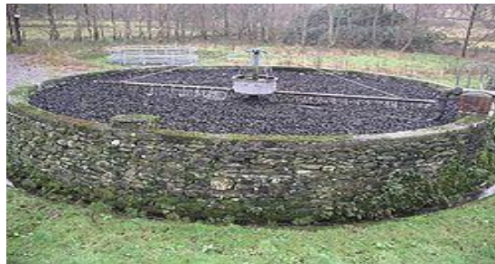
Figura II.4: Camas Filtrantes de oxidación
