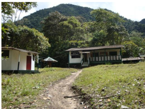
Foto. 21. Centro de administración del PNP
