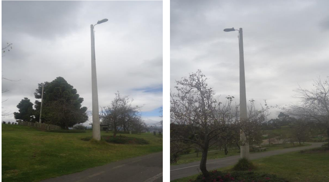
Figura N° 6.36 Poste de las Granjas Elaborado por: David Montesdeoca
