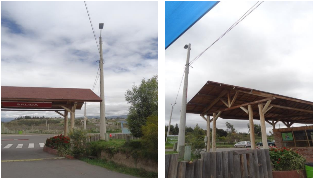
Figura N° 6.35 Poste del Parqueadero Elaborado por: David Montesdeoca
