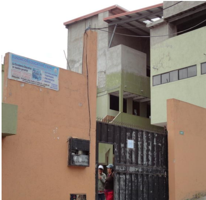
Estructura de la Unidad Educativa Cristiana “ Victoria de la Fé”
