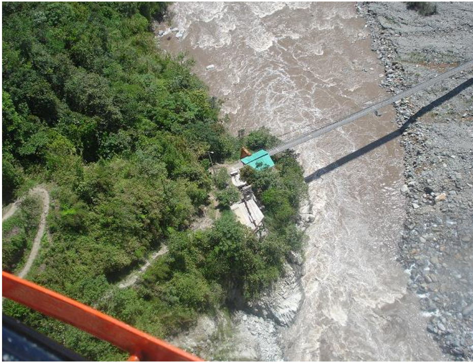
RÍO PASTAZA- PUENTE COLGANTE CHINCHÍN
