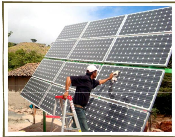
Figura 6.27 Limpieza de los módulos fotovoltaicos
