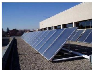
Figura 6.1 Colocación de los Paneles
