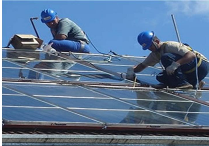
Figura 6.28 Inspección de conexiones en los módulos
