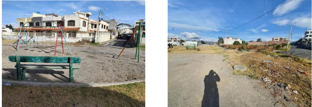
Figura 3. Espacios abandonados en el parque lineal Quebrada seca.
