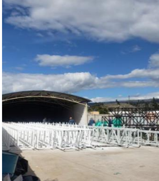
Figura 36.- Pintura de cerchas en el taller
