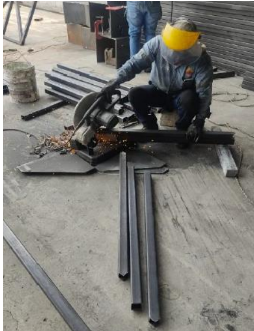
Figura 33.- Proceso de corte cercha
