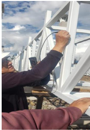
Figura 35.- Inspección de soldadura
