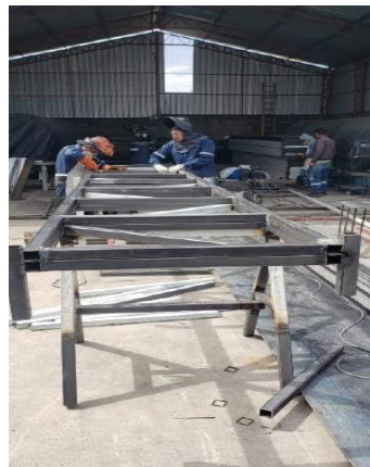
Figura 34.- Armado de la Cercha
