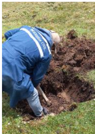
Figura 27. Extracción muestras de suelo por calicata generada
