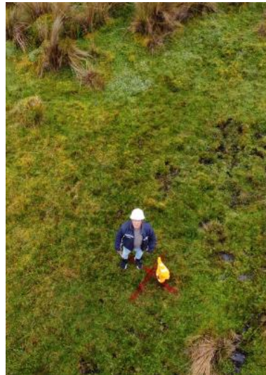
Figura 25. Colocación de estacas en los puntos de control
