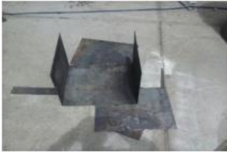
a. Corte y doblado de placas para el tanque
