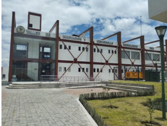
Figura 8. Instalaciones externas del Taller FISEI
