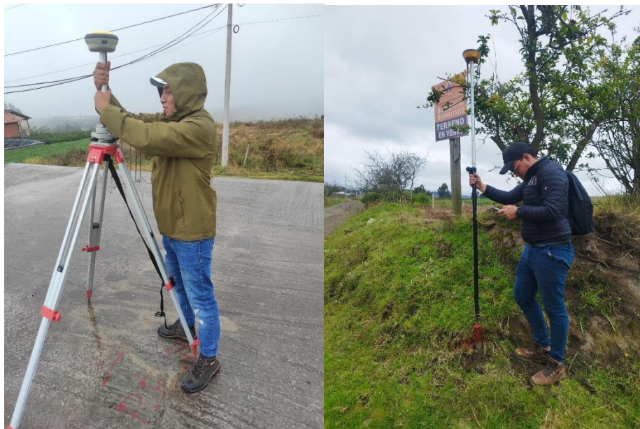
Figura 3. Levantamiento topográfico de la vía
