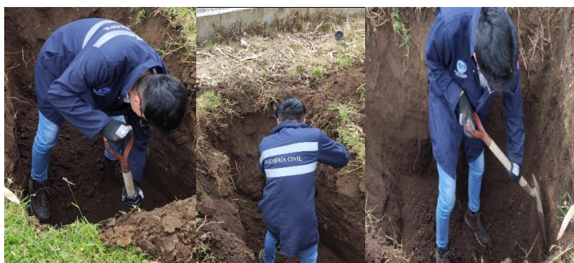
Figura 1. Pozo a cielo abierto
