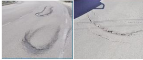
Fig. N° 21 GRIETA PARABÓLICA
