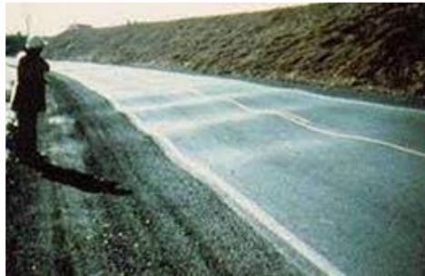
Fig. N° 24 LOSAS DIVIDIDAS
