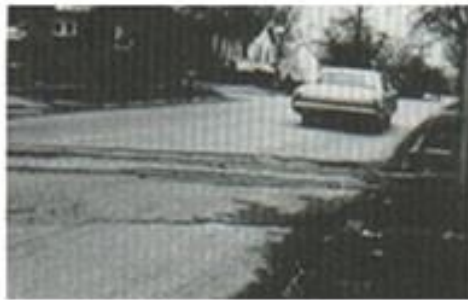
Fig. N° 18 CRUCE DE VÍA FÉRREA
