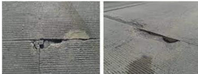
Fig. N° 28 DESCASCARAMIENTO DE JUNTA
