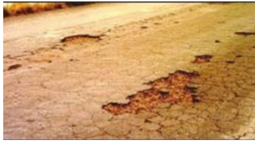
Fig. N° 23 METEORIZACIÓN
