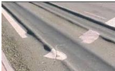
Fig. N° 20 DESPLAZAMIENTO
