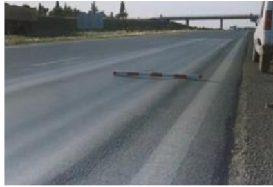
Fig. N° 19 AHUELLAMIENTO
