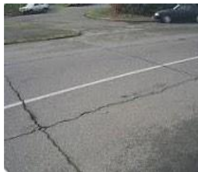
Fig. N° 11 Fig. N.º.- 11 REFLEXIÓN DE JUNTA
