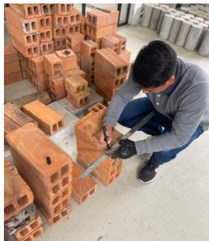
Figura 29: Señalización de ladrillos
