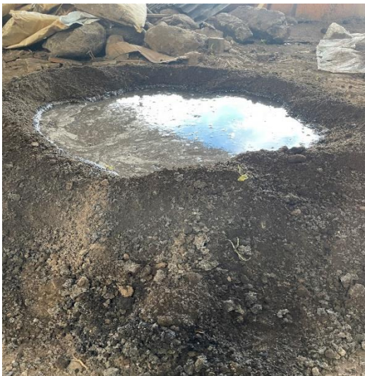
Figura 10: Humectación de material con agua
