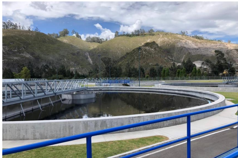
Figura 3: Decantador secundario
