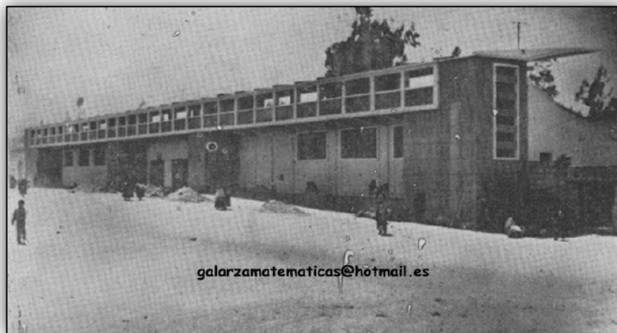
Figura No. 1. Tribuna del Estadio Bellavista en construcción en 1950. Galarza (2017).
