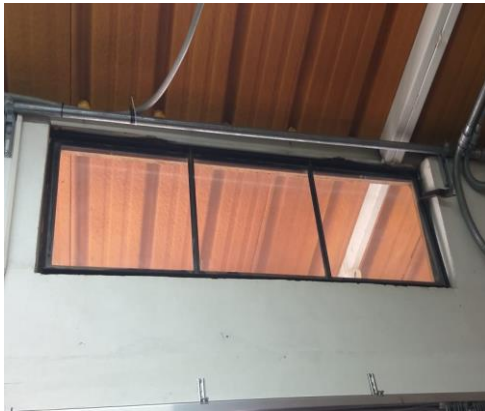
Cables y tuberías sin señalización
