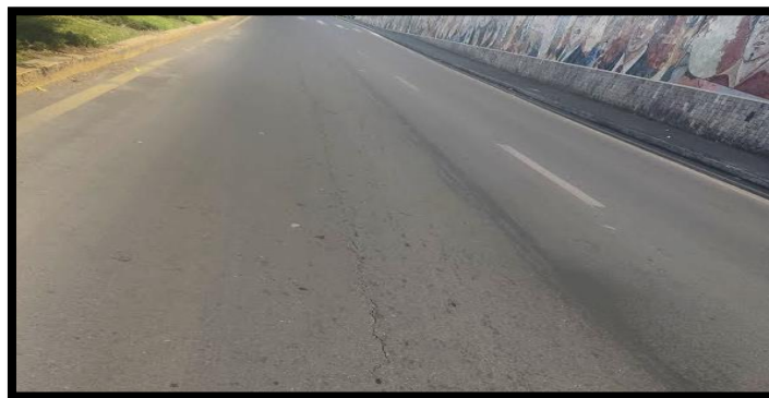
Figura 17. Ahuellamiento.
