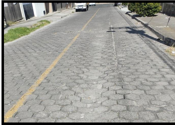
Figura 32. Ahuellamiento
