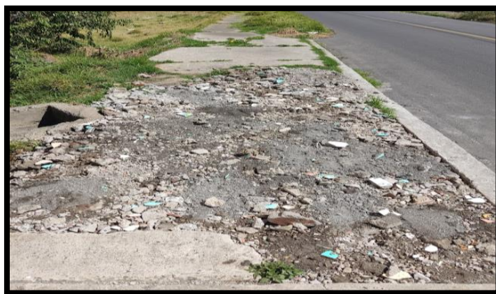
Figura 22. Elementos Faltantes
