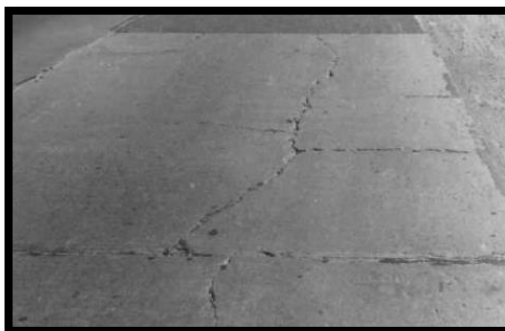
Figura 25. Losas Divididas.
