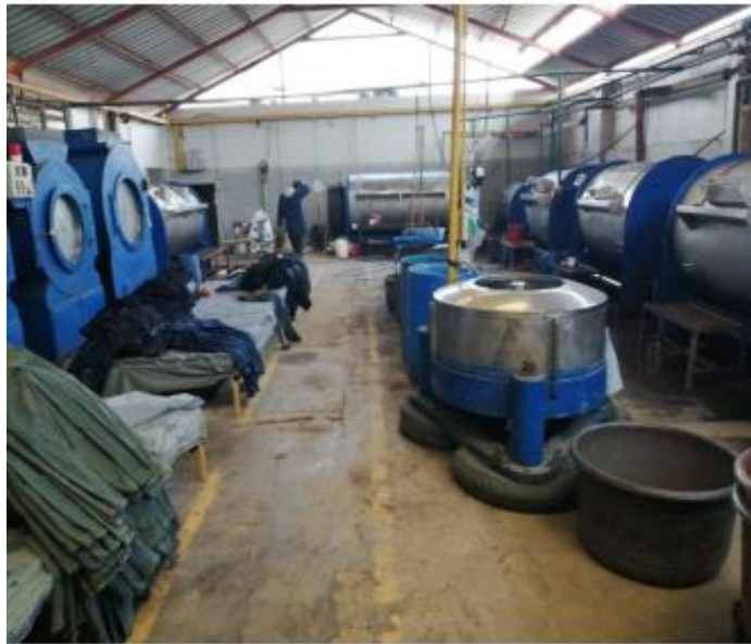
Fig. 10 Área de lavado
