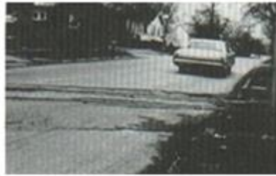
Fig. N.º.- 18 CRUCE DE VÍA FÉRREA
