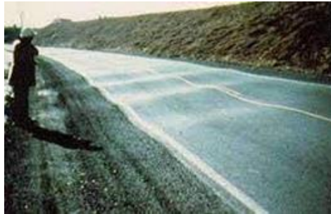
Fig. N.º- 24 LOSAS DIVIDIDAS
