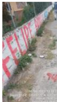
Fig. N.º- 56 HINCHAMIENTO ZONA 4
