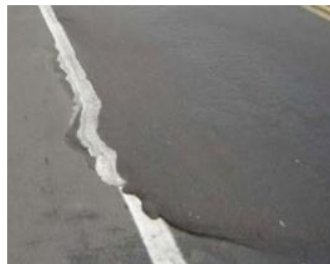
Fig. N.º- 7 ABULTAMIENTO Y HUNDIMIENTO
