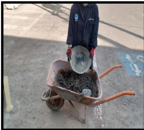
Fotografía 27: Realización del hormigón.
