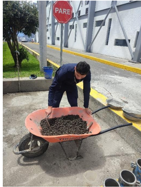
Preparación de la mezcla manualmente
