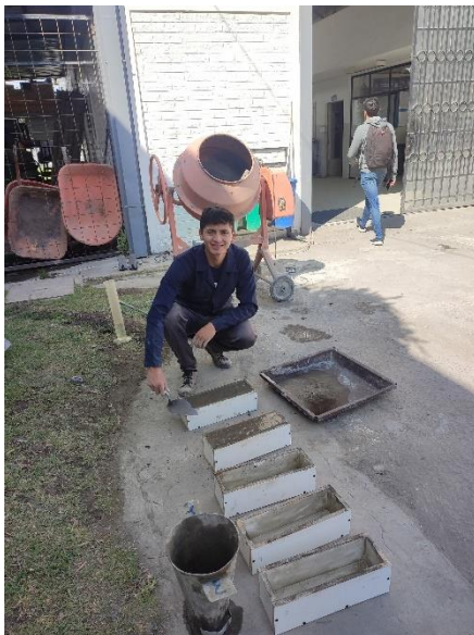
Colocación del hormigón en los moldes
